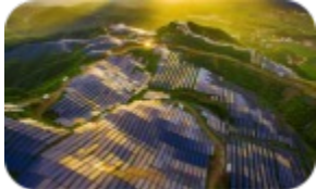
光伏储能逆变
